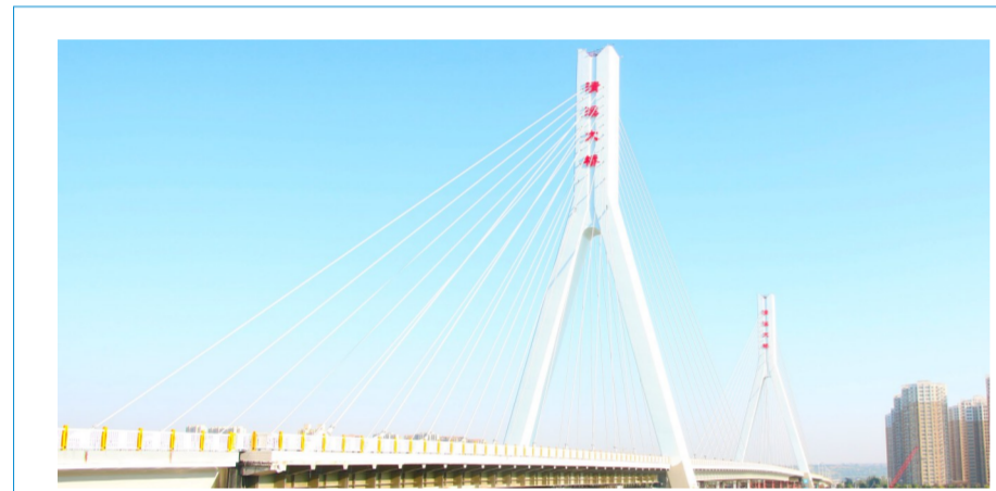
由中建七局承建的陕西宝鸡清溪渭河大桥项目通过竣工验收,大跨度“双塔凌云”亮相。宝鸡清溪渭河大桥主线全长1.1千米,共包含2座索塔、80根钢索以及588米钢混叠合梁。项目建成后,宝鸡清溪渭河大桥将不仅是一座网红打卡地,更能引导交通参与者的出行方式由机动车向绿色交通转变。(石野)
