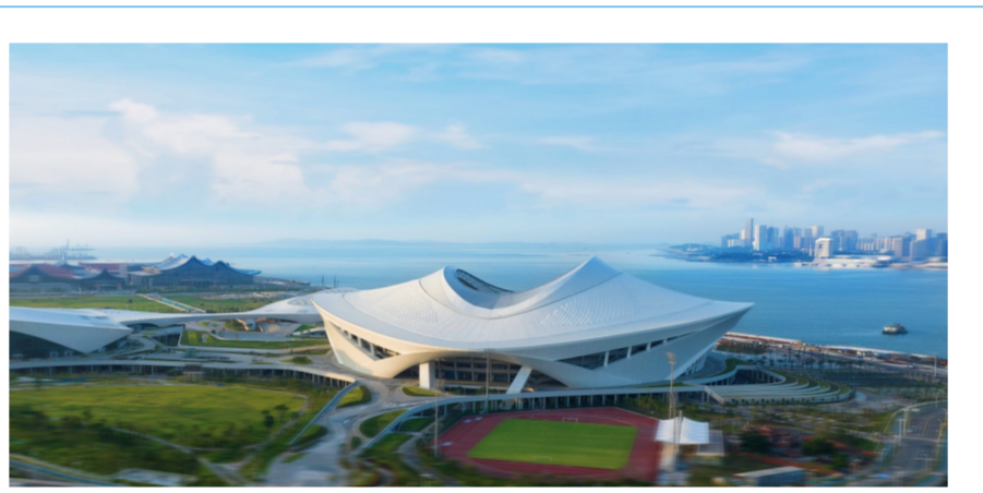
由中建八局承建的厦门新体育中心白鹭体育场项目通过竣工验收。项目总建筑面积18.06万平方米,建筑高度为86.25米。项目是全国首座、世界第三座可实现专业足球场与综合运动场自由转换的体育场,是厦门市实施“千亿产业、跨岛发展”的重大战略举措,建成后将成为厦门城市新地标。(后越)
