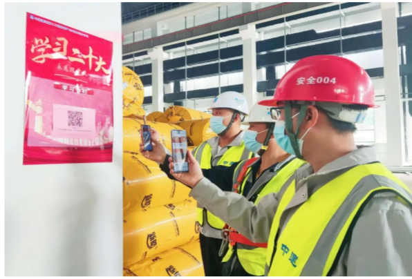
在成都中科院光电所项目现场,中建二局西南公司组织一线建设者开展党的二十大精神“码”上学活动。
