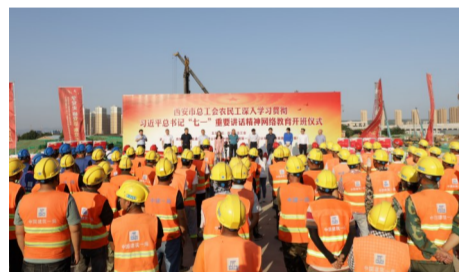
中建一局一公司西安地铁八号线项目农民工学习习近平总书记“七一”重要讲话。
