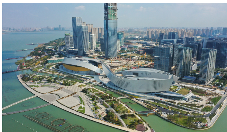
5月12日，中建三局承建、中建安装参建的苏州湾文化中心项目全面竣工。项目以“双飘带”立面交织起两大标志场馆，是全国首个将大剧院、影院、博物馆、会议中心、规划馆等场馆和功能融入一体的城市文化综合体。(赵梦梦、王灿华)
