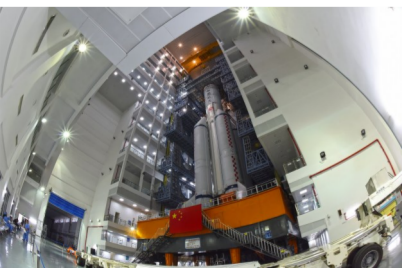
新一代运载火箭力学试验与发射测试厂房建造关键技术 2017年 国家科学技术进步奖 二等奖
