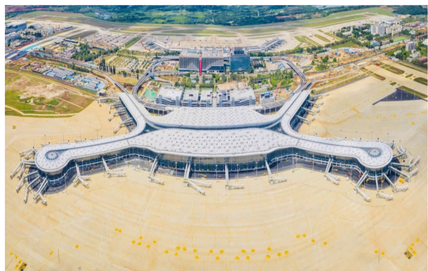
近日,中建八局承建、中建安装参建的海口美兰国际机场二期扩建项目T2航站楼工程顺利通过竣工验收,向年底正式通航迈出坚实一步。(谭健、张美怡)
