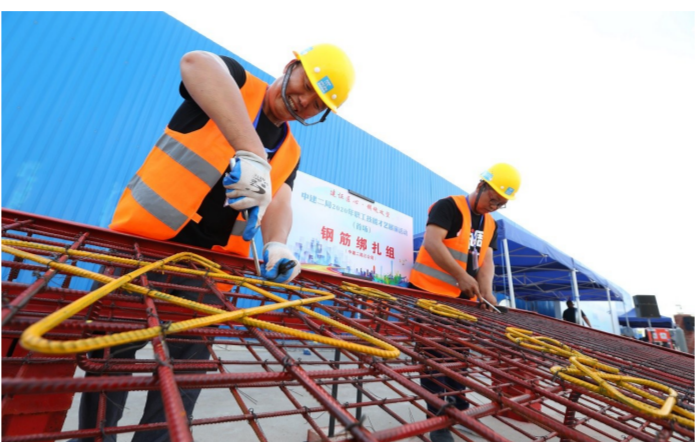
中建二局华北公司万科项目,塔吊、砌筑、电焊、机电、钢筋五大板块工人各显神通,“红色先锋”助力新时期产业工人队伍建设。
